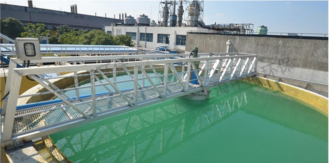
污水从池中心的进水管经导流筒扩散后，均匀地向周边呈辐射状流出，呈悬浮状的污泥经沉淀后沉积于池底，上清液通过溢流堰板由出水槽排出池外，污泥刮板由池周刮向中心集泥槽，依靠池内水压通过排泥管排出池外。主梁在周边驱动装置的带动下，以中心旋转支座为轴心沿池顶以 $2.0\text{m/min}$ 线速度行驶，主梁下部连接支架、污泥刮泥板等。近液面处设置浮渣刮板，沿中心稳流筒延伸至铰链式刮渣耙，当主梁旋转时，浮渣刮板将液面的浮渣由池中心撇向池周，收集在铰链式刮渣耙区内，收集的浮渣随主机在池周运动至撇渣斗，通过刮渣耙的铰链活动刮至撇渣斗内，排至池外。
